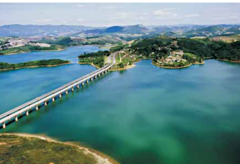
Rodovia Dom Pedro II sobre o corpo central do Reservatório Atibainha, núcleo urbano de Nazaré Paulista ao fundo. Foto: Iatã Cannabrava/ISA (dez/03)
