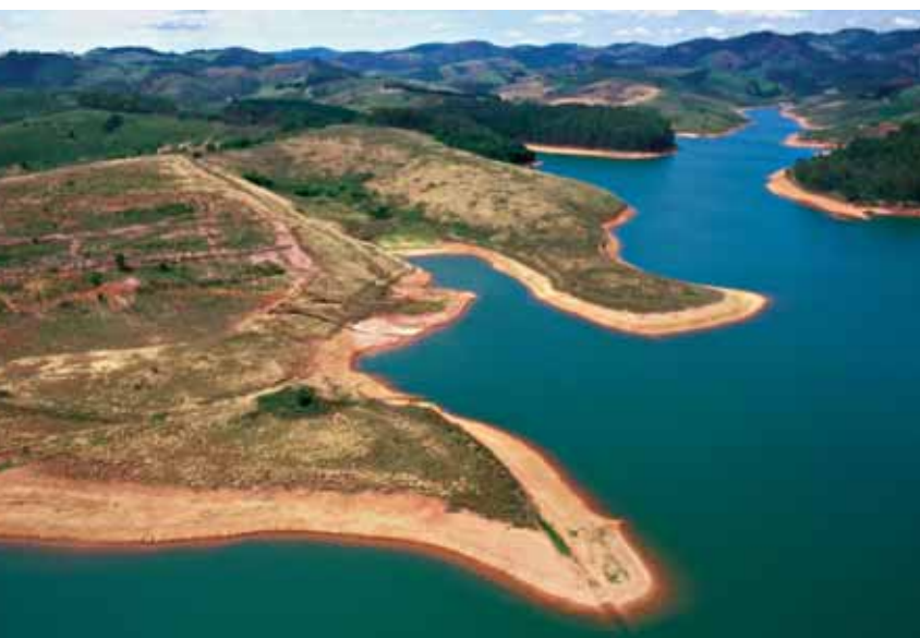
Margem do Reservatório Cachoeira com processo acelerado de erosão em suas margens. Nota-se a grande extensão de áreas ocupadas por campos antrópicos e a baixa presença de vegetação. Foto: Iatã Cannabrava/ISA (dez/03).
