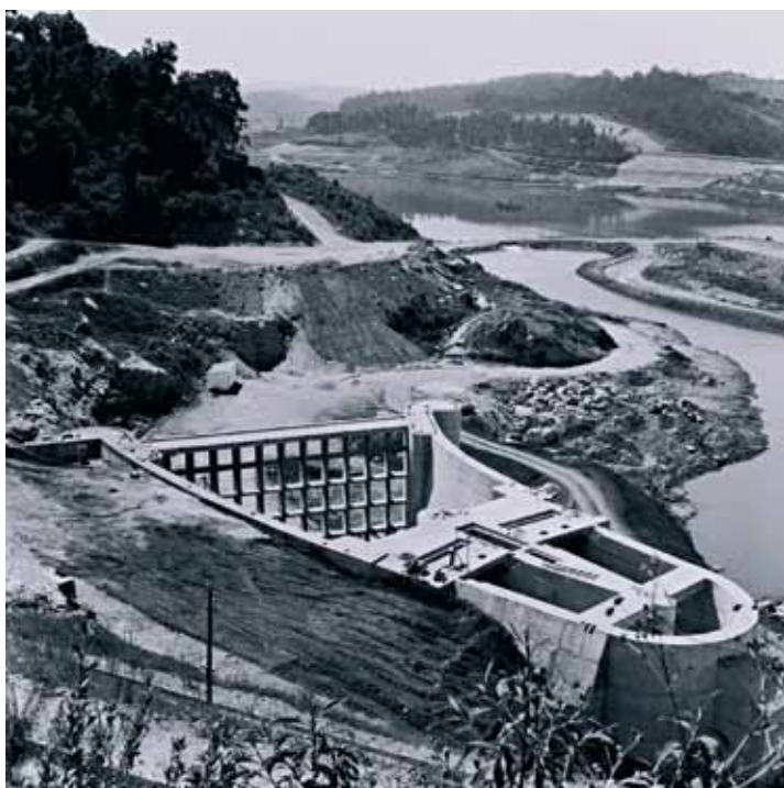
Construção do Reservatório do Rio Juquery, ou Paiva Castro. Foto: Arquivo Sabesp.
