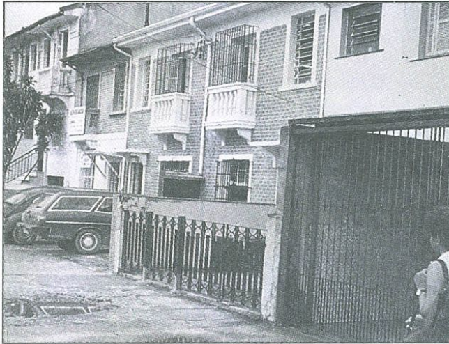
Cortiços que foram reformados e transformados em casas de uso comercial - Ponte Pequena
