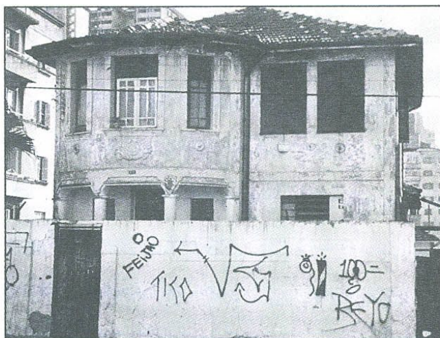
Sobrado encortiçado - Rua Vergueiro
