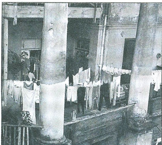
Casarão parcialmente encortiçado - Vila Iitororó
