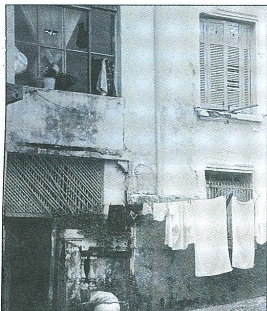
Sobrado encortiçado - Rua Conselheiro Ramalho
