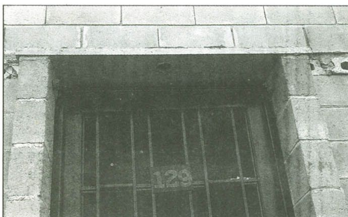
Robson Martins - Habi Detalhe de acabamento. Jardim São Francisco
