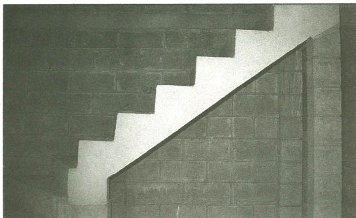
Robson Martins - HABI Componente pré-moldado da escada. Jardim São Francisco
