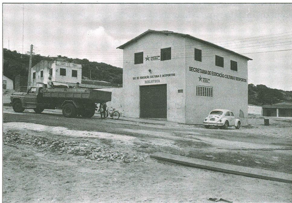
Prédio que abriga a Secretaria e a Biblioteca.
