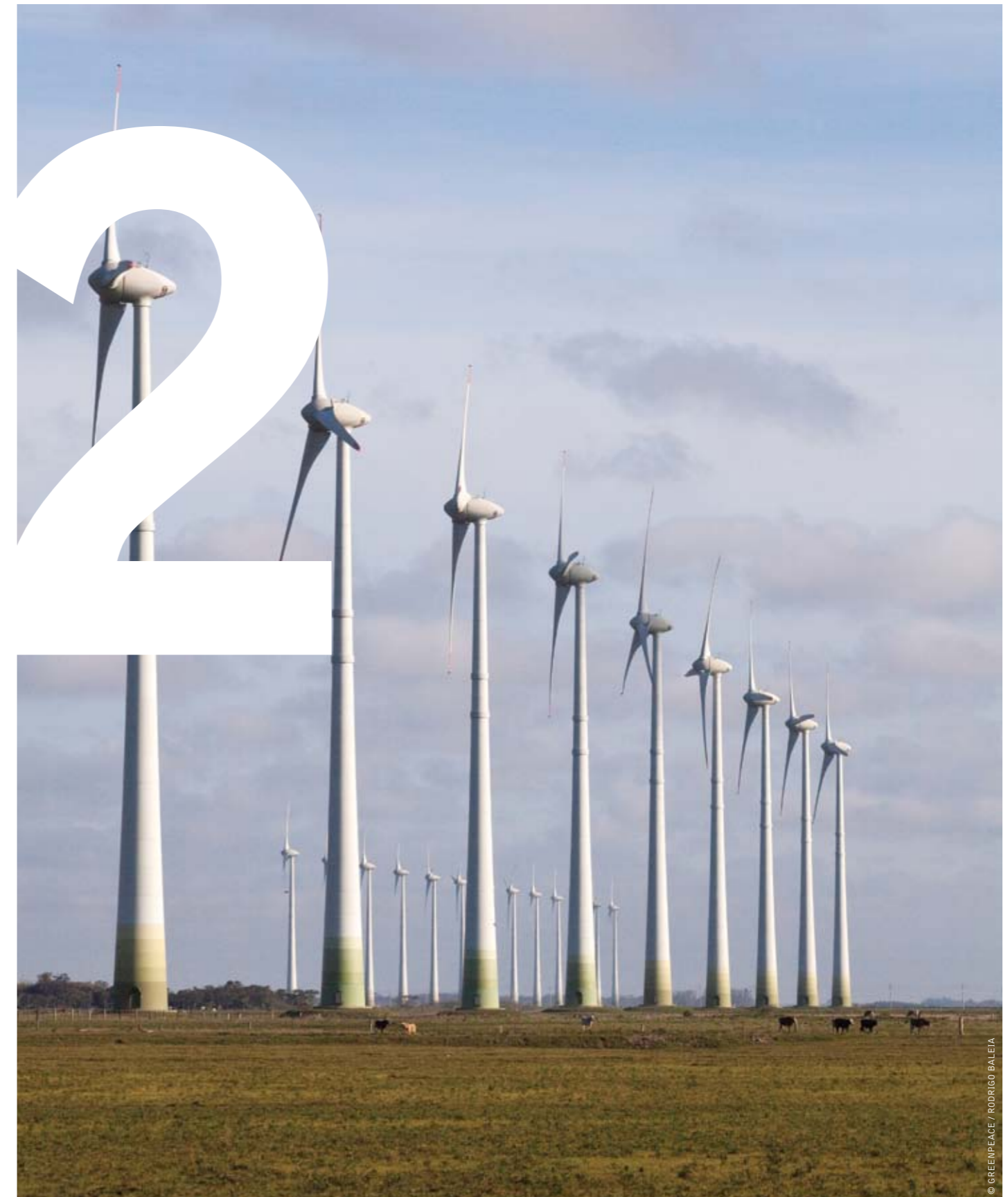
imagem PARQUE EÓLICO DE OSÓRIO, RIO GRANDE DO SUL.
